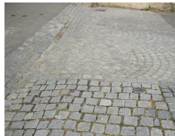
Réfection de joints en résine (en haut) à Mittelbergheim
